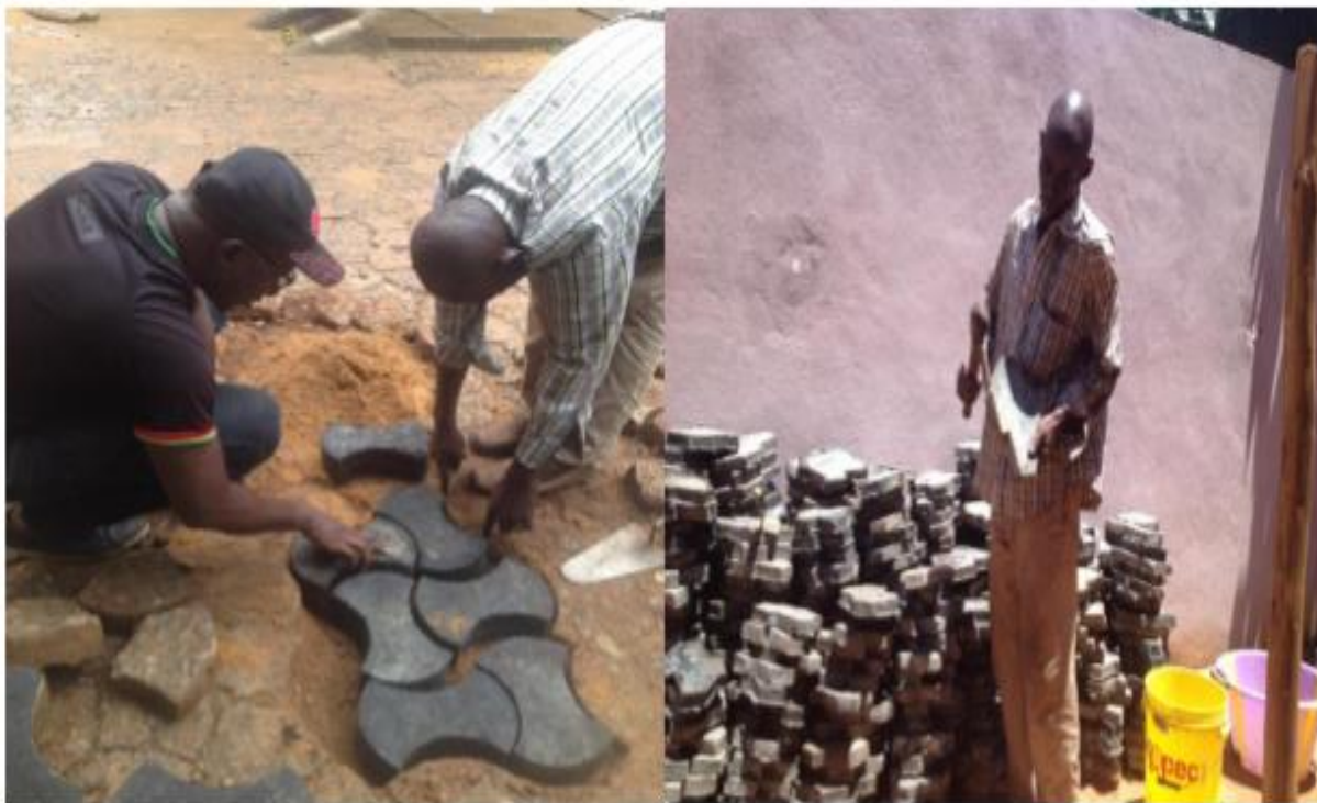
Figure 15: Réalisations d'une section de pavage de pavage dans la cour de l'Ecole de Nationale d'Ingénieurs (ENI-ABT) de Bamako.
