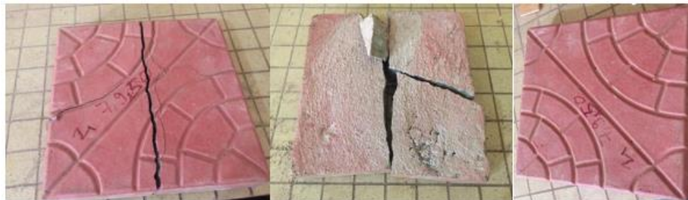
Figure 16: Pavés de bétons A) Ecologique et B) Conventiennel avant et après le test de resistance
